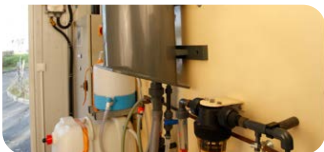
Dans l'industrie du process : TetraCon® 700 IQ sonde de conductivité 4-électrodes
