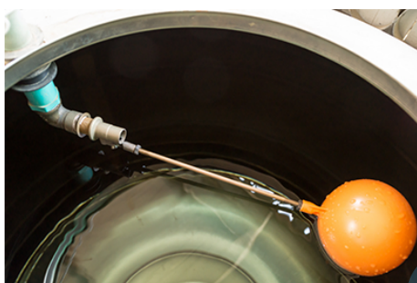
Interrupteur à flotteur de régulation de niveau
