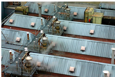
Réservoirs de toit
