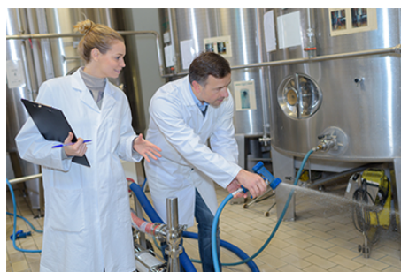
Installation de nettoyage dans une laiterie
