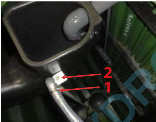
Les diffuseurs d'air avec tuyau en acier inox (VODALYS 14 EH)
