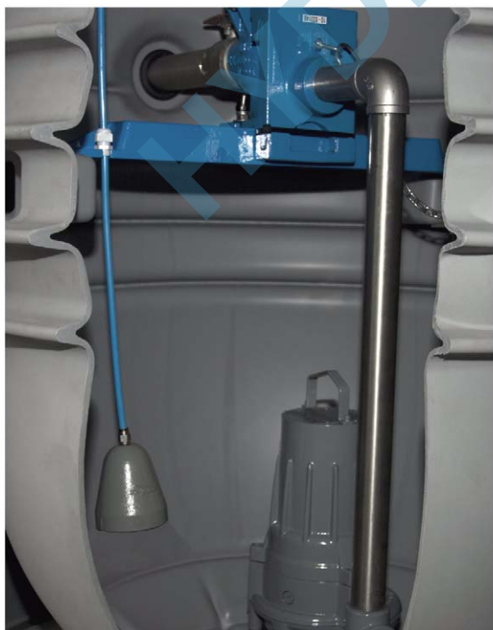
Composants du système Open Bell : 1. cloche en fonte ; 2. fixation du tube ; 3. tube pneumatique (10 mm) ; 4. couvercle vissant ; 5. réduction
